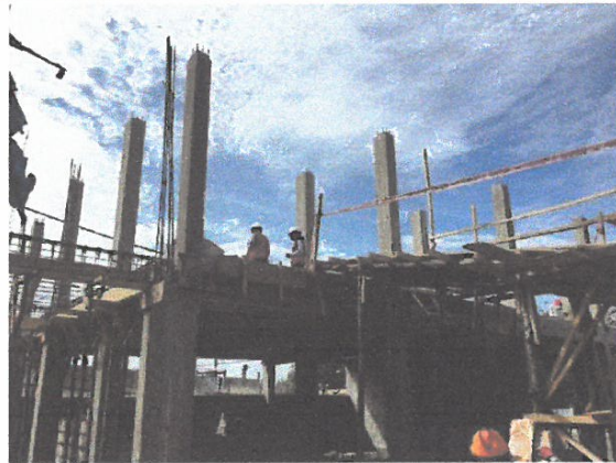
VACIADO DE COLUMNAS DEL SEGUNDO NIVEL, ASISTENTE DEL SUPERVISOR ESTUVO VERIFICANDO EN LA EJECUCIÓN, LUEGO VERIFICARON LA CALIDAD DE LO EJECUTADO.
