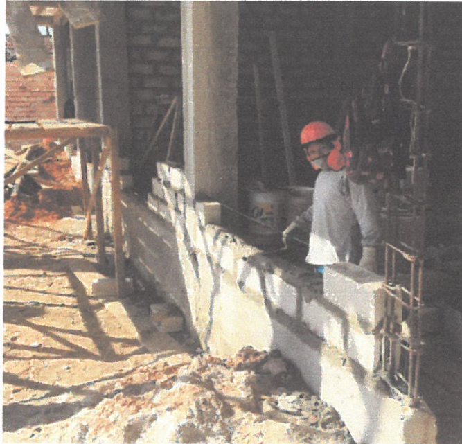
IMAGEN 03 Asentado de ladrillo de aula primer piso
