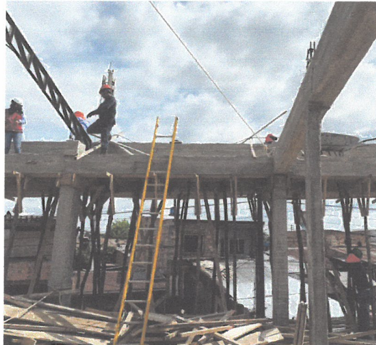
IMAGEN 05 Colocación de tijerales metálicos
