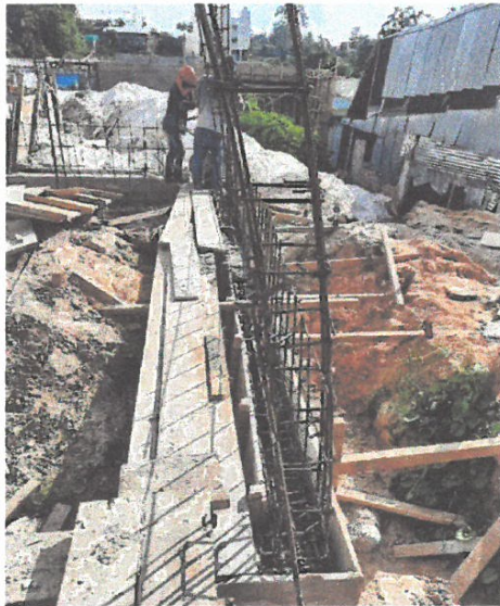
VACIADO DE VIGAS DE CIMENTACIÓN DEL CAFETIN
