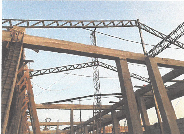
IMAGEN 06 Colocación de tijerales metálicos
