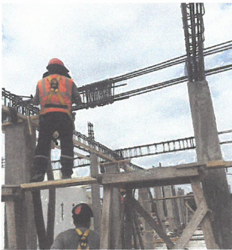
HABILITACIÓN DE ACERO DE VIGAS – VA-1
