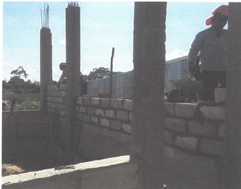
IMAGEN 04 Asentado de ladrillo de cafetín
