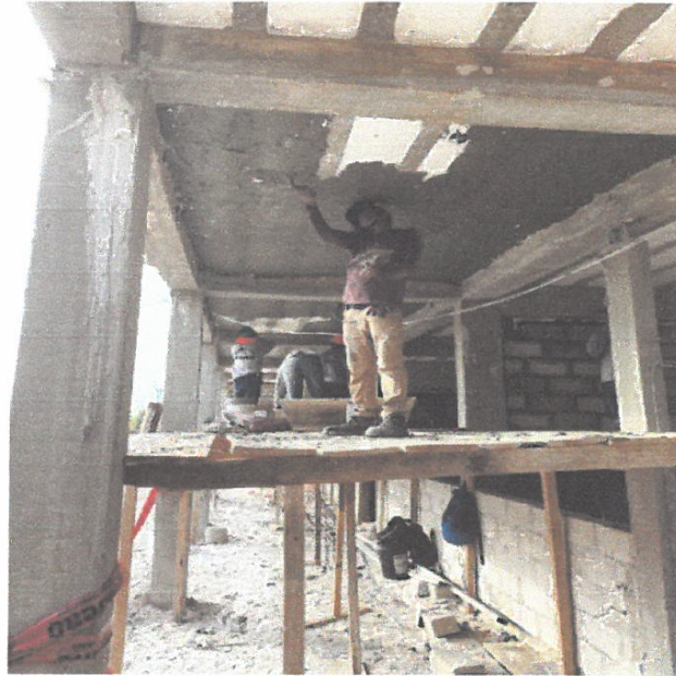
IMAGEN 07 Tarrajeo de losa
