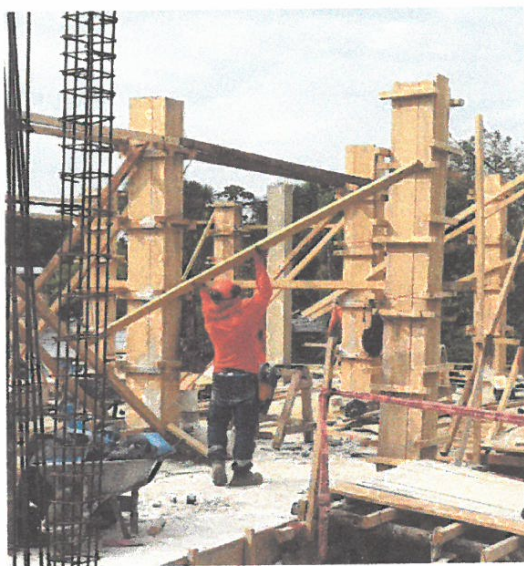
HABILITACIÓN DE FIERROS Y ENCOFRADO DE COLUMNAS, SEGUNDO NIVEL
