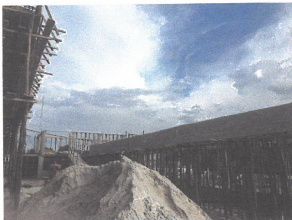
VACIADO DE VIGAS Y CANALETA DE MORTERO, DE AULAS DE UN SOLO NIVEL.
