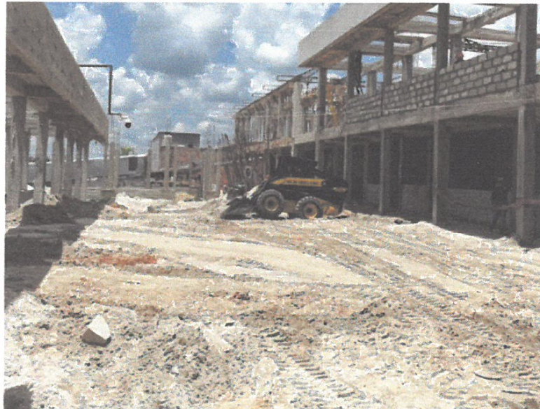
IMAGEN 08 Relleno material de compacto con maquinaria pesada
