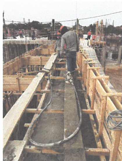
VACIADO DE COLUMNAS DEL SEGUNDO NIVEL, ASISTENTE DEL SUPERVISOR ESTUVO VERIFICANDO EN LA EJECUCIÓN, LUEGO VERIFICARON LA CALIDAD DE LO EJECUTADO.
