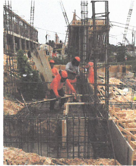
HABILITACIÓN DE FIERRO Y ENCOFRADO DE VIGAS DE CIMENTACIÓN DEL CAFETIN
